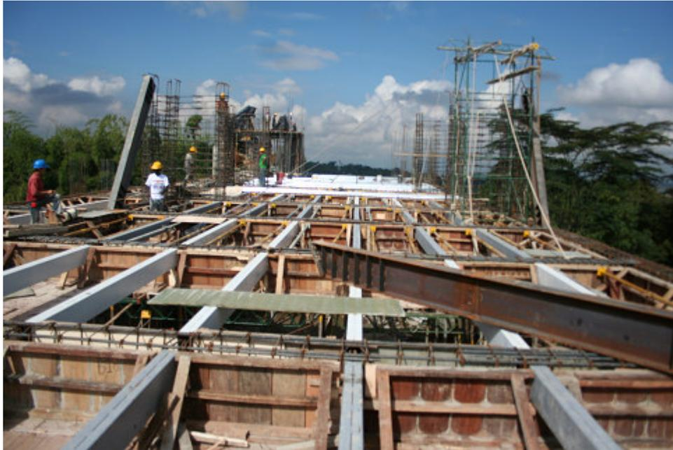
Armado placa nivel +14.60 (último piso) bloque norte y escaleras de acceso y columnas hasta nivel +18.25
